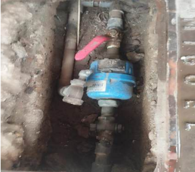
CASA FISCAL- SECTOR LA CANCHA ANTES
