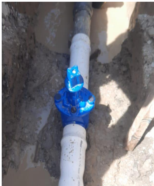
Cambio de válvula de la calle 33 con carrera 4 sector Guayabera (esquina solar María Eugenia Ruíz)
