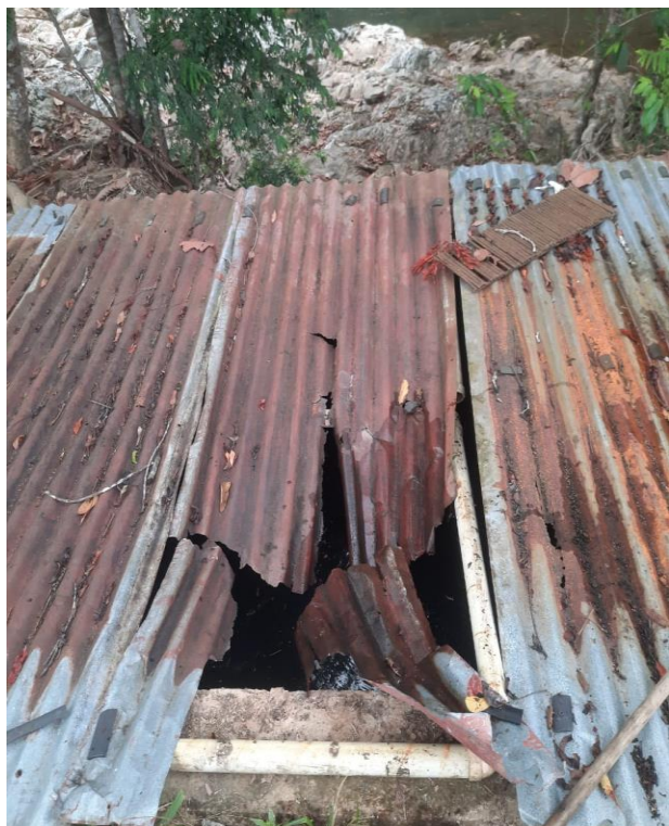
Mantenimiento del tanque desarenador
