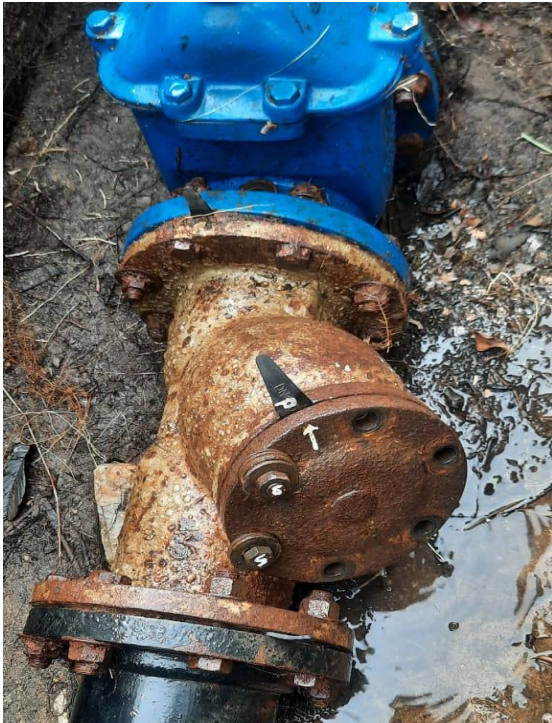
LIMPIEZA DEL MACROMEDIDOR DE 6" Y 4"
