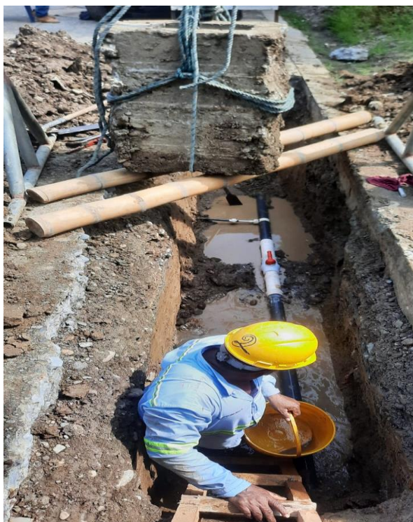
Cambio de válvula carrera 5 con
