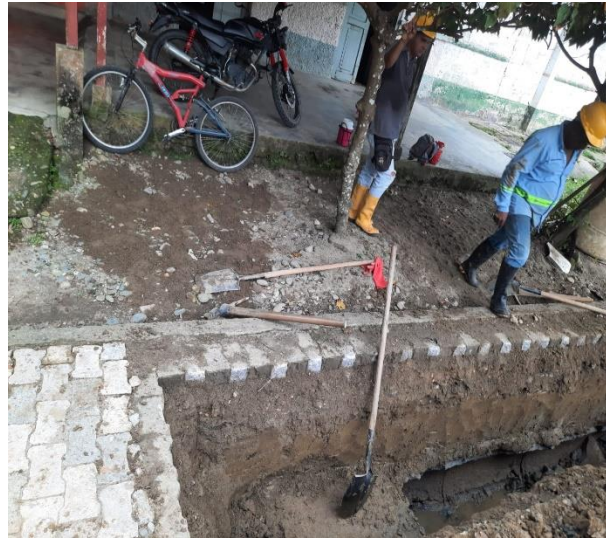
Terminación de cambio de alcantarillado calle 30 entre carrera 2 y 1 sector cancha
