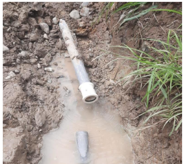
Arreglo de red principal (conexión) calle 33 con carrera 6 sector Guayabera
