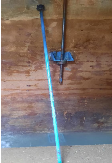
Arreglo compuerta del filtro 1
