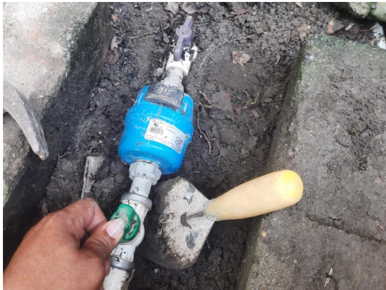
Cambio de contador Ana Rita Zapata
