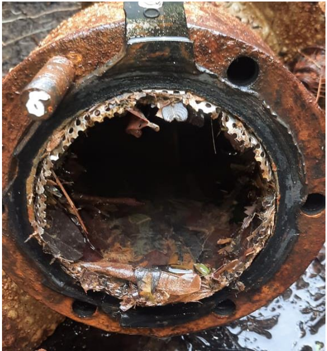
LIMPIEZA DEL MACROMEDIDOR DE 6" Y 4"
