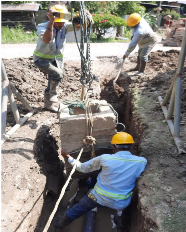
Cambio de válvula carrera 5 con
