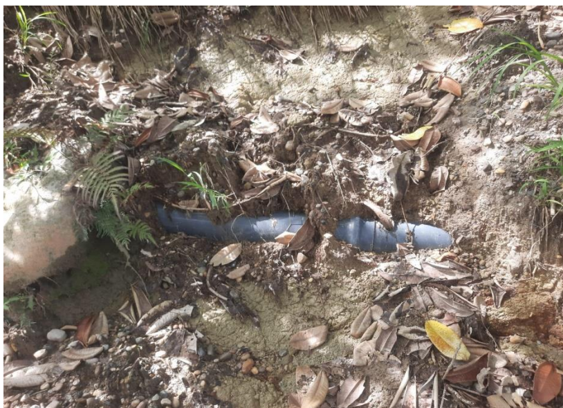
Mantenimiento red principal acueducto lugar Maquenque
