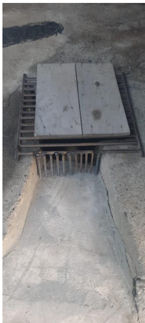
Mantenimiento rejilla de aguas lluvias sector Cancha (Graciela Gómez)
