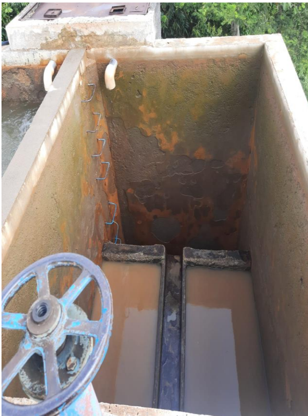
Lavado de los filtros
