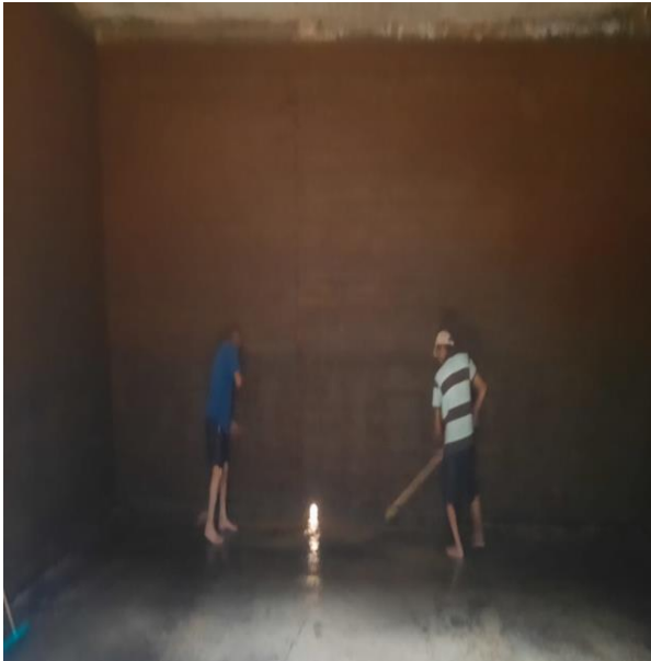
Tanque de almacenamiento
