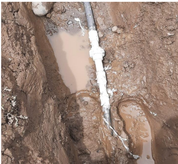
Arreglo de red principal (conexión) calle 33 con carrera 6 sector Guayabera
