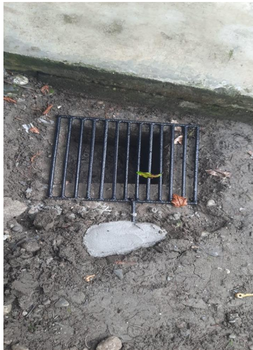
Instalación de rejillas en cajas de aguas lluvias en el sector Guayabera
