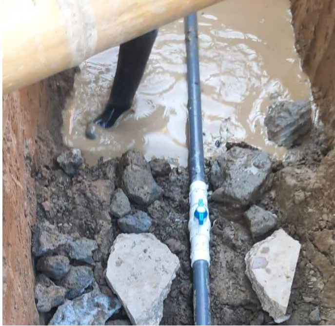
Arreglo daño en la válvula de la calle 33 con carrera 4 (esquina María Eugenia Ruiz)
