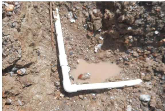
Reparación red principal salida Piedras Blancas sector Guayabera
