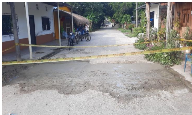
Arreglo calle 32 carrera 5 sector Guayabera
