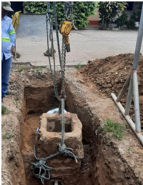
Cambio de válvula carrera 3 calle 27 esquina (José Corrales)
