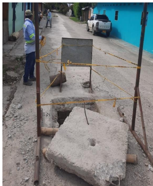
Mantenimiento de caja de inspección en la carrera 3 con calle 33 esquina Costeña
