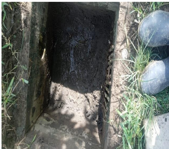
Limpieza de cajas de aguas lluvia Sector Cancha
