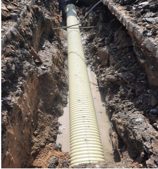
Terminación de cambio de alcantarillado calle 30 entre carrera 2 y 1 sector cancha
