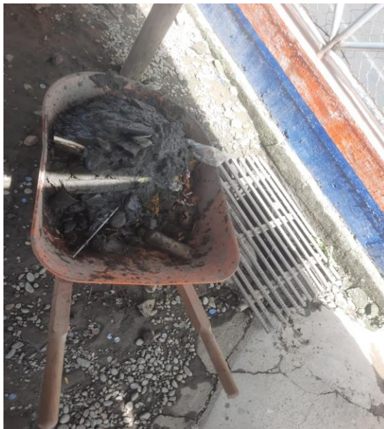
Limpieza de cajas de aguas lluvias sector Comercio
