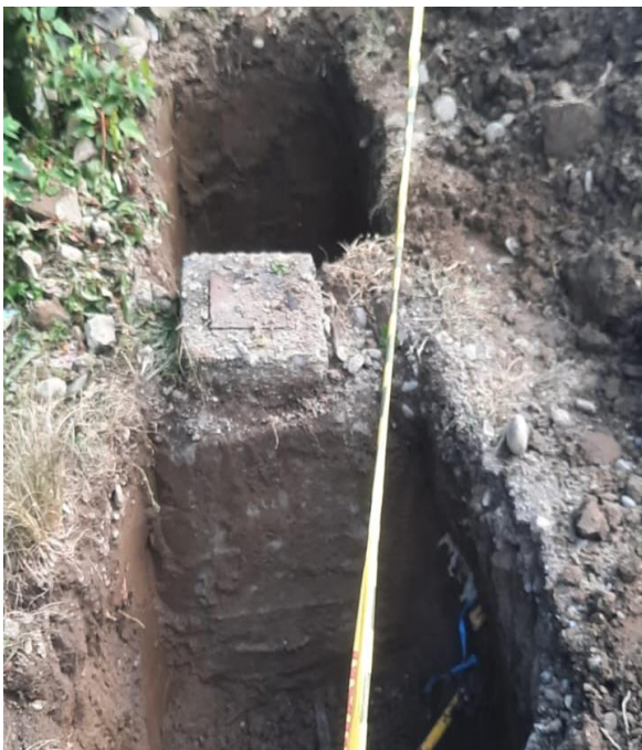
Cambio de válvula en la carrera 2 con calle 27 sector Chirivicos
