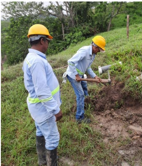
Arreglo en la red principal parte baja de los tanques
