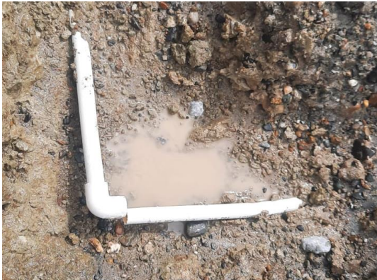
Arreglo red principal vía Piedras Blancas
