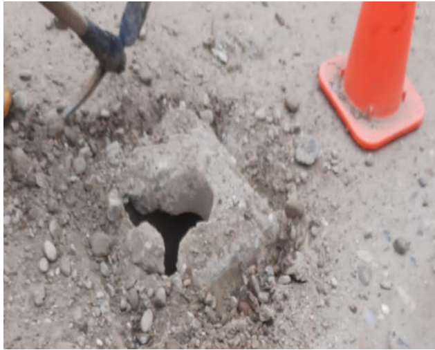
Cambio de tapa válvula cra 3 con calle 31
