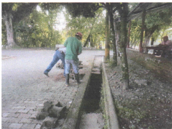
Arreglo de alcantarillado calle30 con carrera 1
