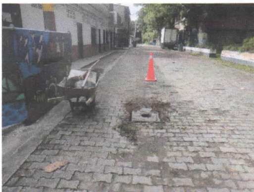
Arreglo caja de válvulas
