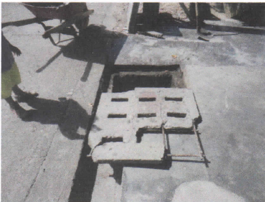
Arreglo tapas de aguas lluvias
