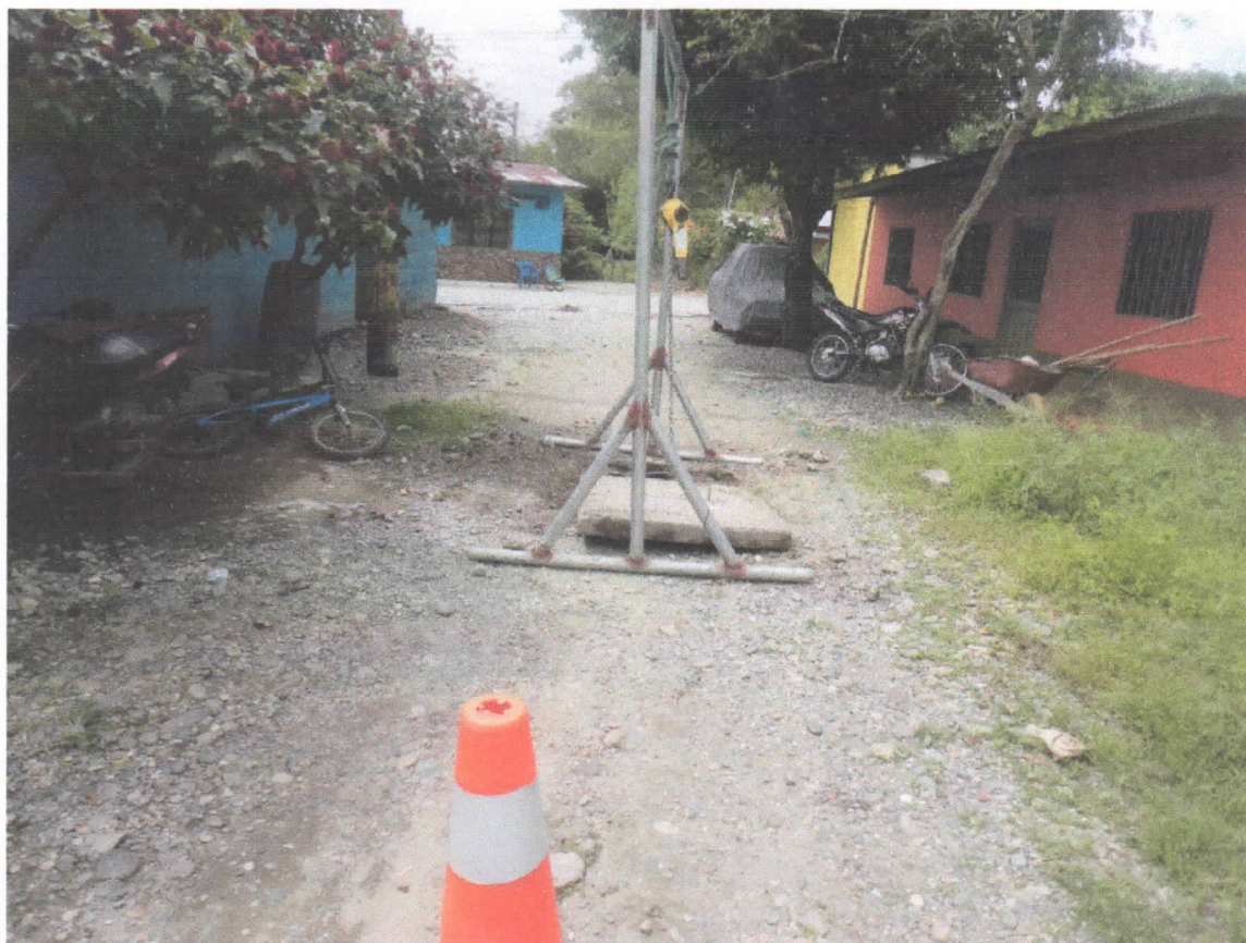
Arreglo ángulo tapa caja de alcantarillado calle 27
