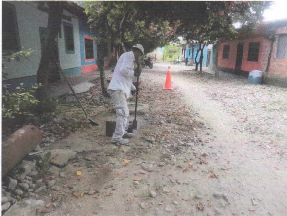
Mantenimiento caja de alcantarillado carrera 5
