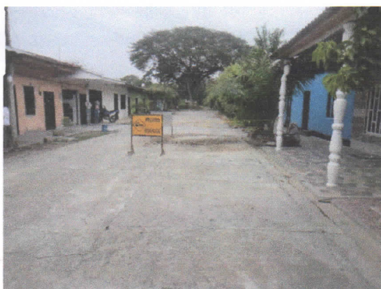
Arreglo cajas de aguas lluvias
