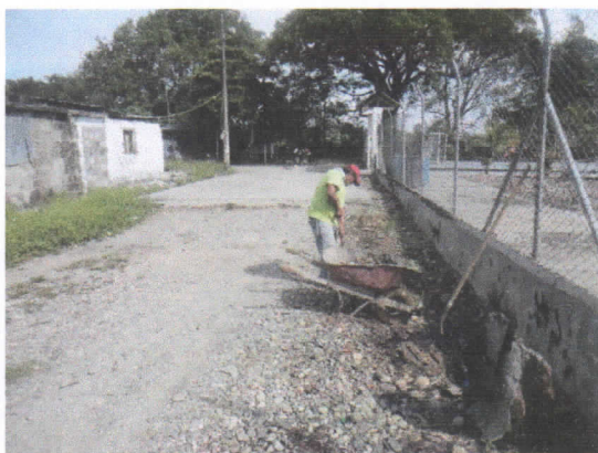
Limpieza de caja de aguas lluvias carrera 6
