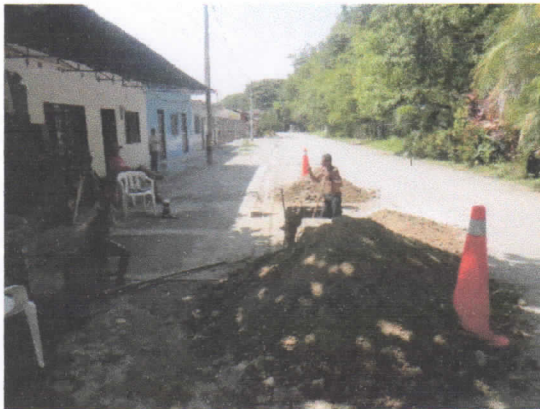
Cambio de válvula carrera 1 con calle 28
