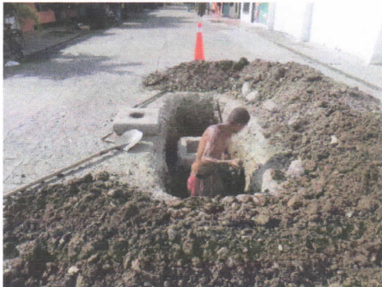
Cambio de válvula carrera 2 con calle 29
