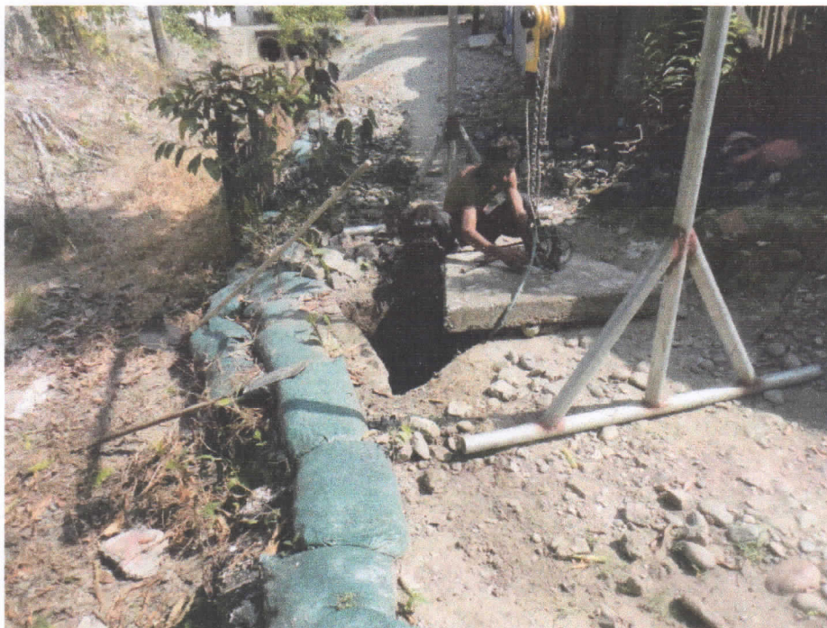
Mantenimiento caja de alcantarillado carrera 5
