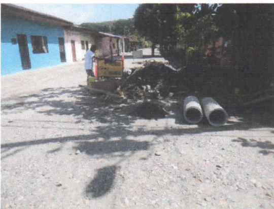
Arreglo alcantarillado calle 32 con carrera 3
